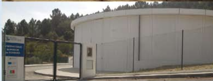
Reforço do abastecimento de água no Fundão - Novos reservatórios com capacidade para 5.000 m³
